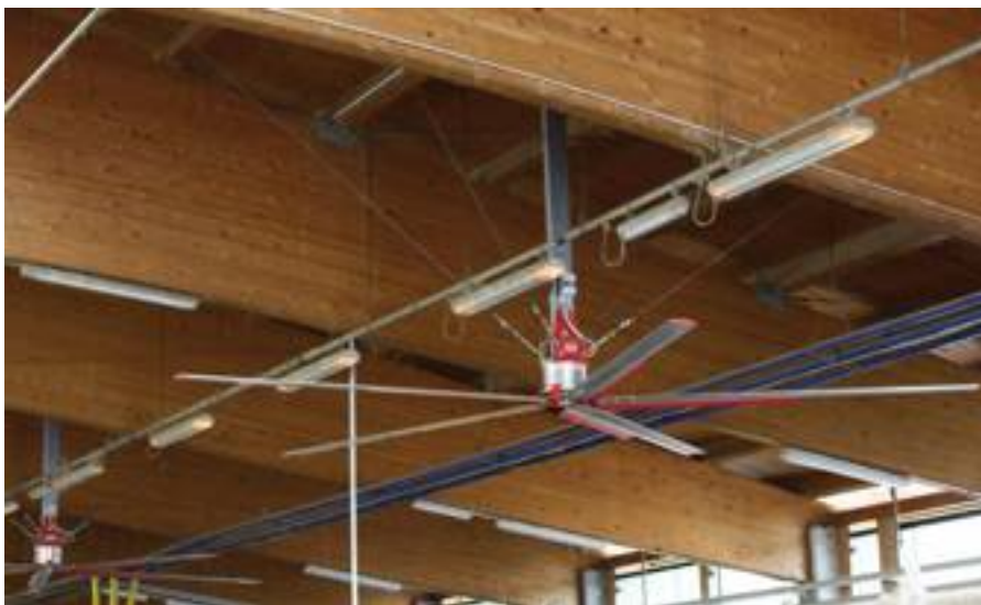
● I destratificatori costruiti da aziende specializzate e sviluppati in modo mirato per garantire una movimentazione di elevati volumi d'aria rappresentano un'innovazione determinante per il settore zootecnico, perché migliorano sensibilmente il microclima di stalla.
