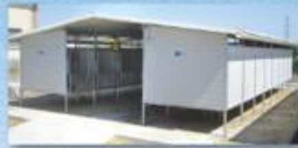
Box svezzamento vitelli a file contrapposte con copertura coibentata per la corsia di servizio.
