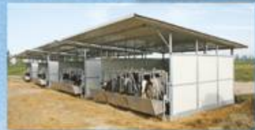
Box accrescimento vitelli con pareti di contenimento e copertura in pannelli coibentati. (cm. 330x330)
