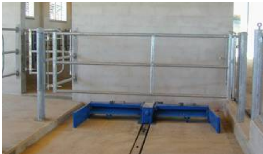
● Il raschiatore meccanico a moto alternato con asta rigida è costituito da un'asta rigida d'acciaio con fori equidistanti, nei quali si innesta il gancio di traino del raschiatore. L'asta è mossa da un pistone idraulico a sua volta azionato da una centralina.
