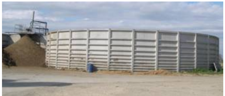
● Una vasca per liquami circolare in elementi prefabbricati di calcestruzzo armato precompresso.
