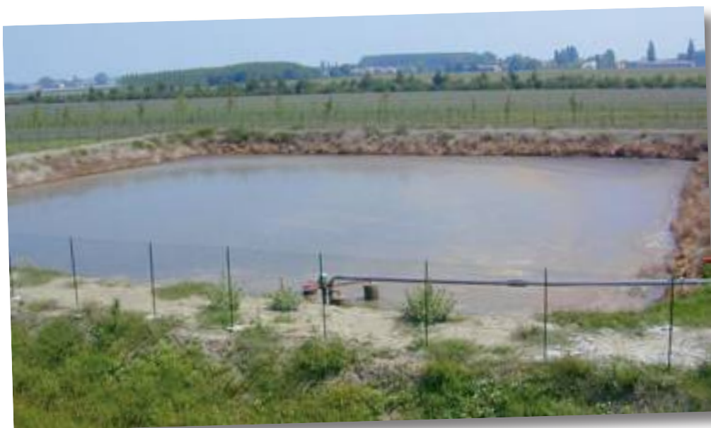
● In confronto alle vasche, le lagune in terra richiedono maggiore occupazione del suolo, una più ampia superficie di raccolta dell'acqua piovana, una più difficile esecuzione delle operazioni di spurgo e un più elevato impiego di manodopera per le operazioni di manutenzione degli argini.
