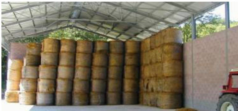
● Un fienile con struttura portante in acciaio, tamponamenti di calcestruzzo alleggerito e copertura con pannelli sandwich.
