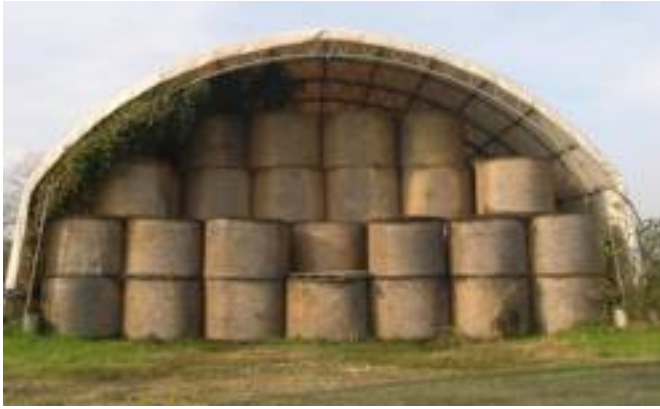
● La copertura dei capannoni deve proteggere il contenuto sia dalle piogge, sia dall'irraggiamento solare, inoltre deve essere resistente di fronte all'attacco di batteri, funghi o altri microrganismi.
